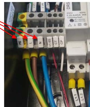
Note: La morsettiera per il cablaggio dell'alimentazione AC supporta dimensioni di cavi fino a 10mmq. Si raccomanda di utilizzare un cavo con singole sezioni di almeno 6mmq. Qualora la distanza fra la scatola di derivazione con il relativo interruttore magnetotermico e differenziale si trovi ad una distanza superiore alla distanza standard potrebbe essere necessario aumentare la sezione dei cavi utilizzati previo calcolo.
