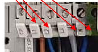
Note: La morsettiera per il cablaggio dell' alimentazione AC supporta dimensioni di cavi fino a 10mmq. Si raccomanda di utilizzare un cavo con singole sezioni di almeno 6mmq. Qualora fra la scatola di derivazione con il relativo interruttore magnetotermico e differenziale e la wallbox ci sia una considerevole distanza potrebbe essere necessario aumentare la sezione dei cavi utilizzati previo calcolo.
